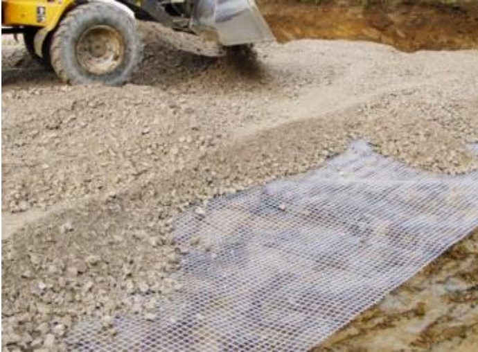
Abbildung 4: Verlegung von Geogitter 39
