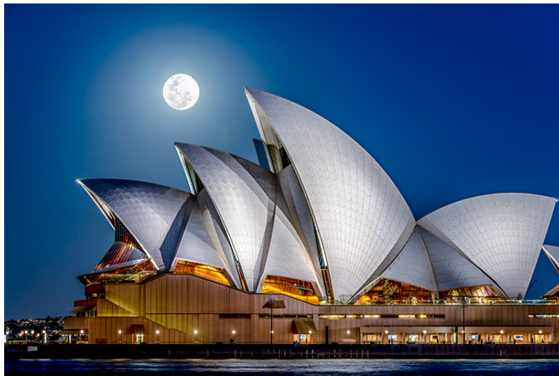
Abbildung 20: Die Dächer des berühmten Opernhauses in Sydney waren aus einer einzelnen Kugel geschnittene Segmente.
