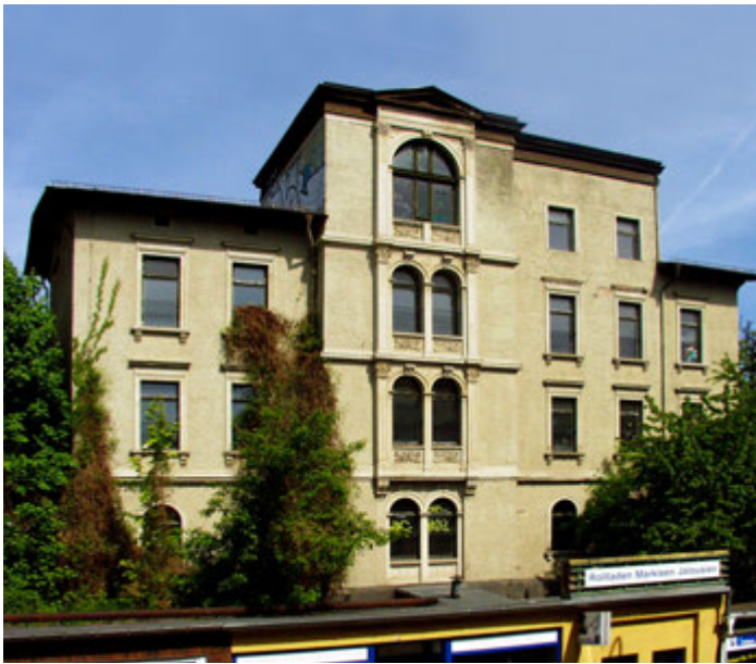
Zustand vor der Sanierung · Westbahnhofstraße 16
