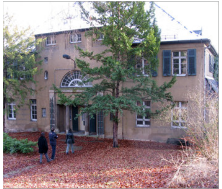
Ansicht vor der Sanierung
