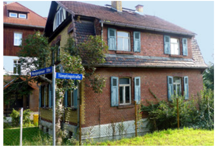
Ansicht vor der Sanierung
