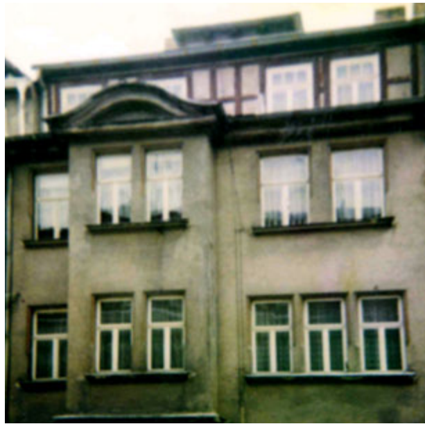
Fassadenansicht vor der Sanierung
