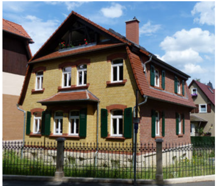
Fassadenansicht Wenigenjenaer Ufer 12
