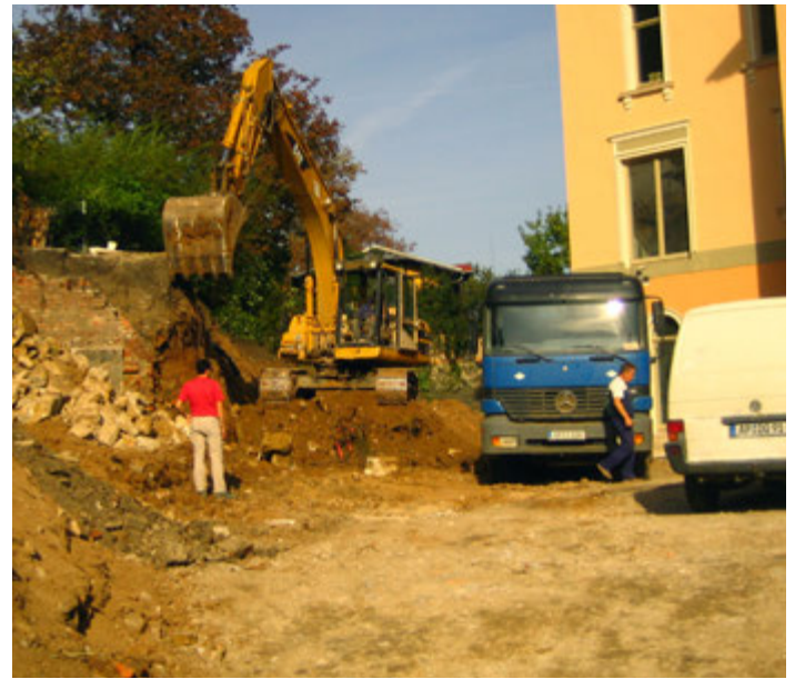
Während der Bauarbeiten
