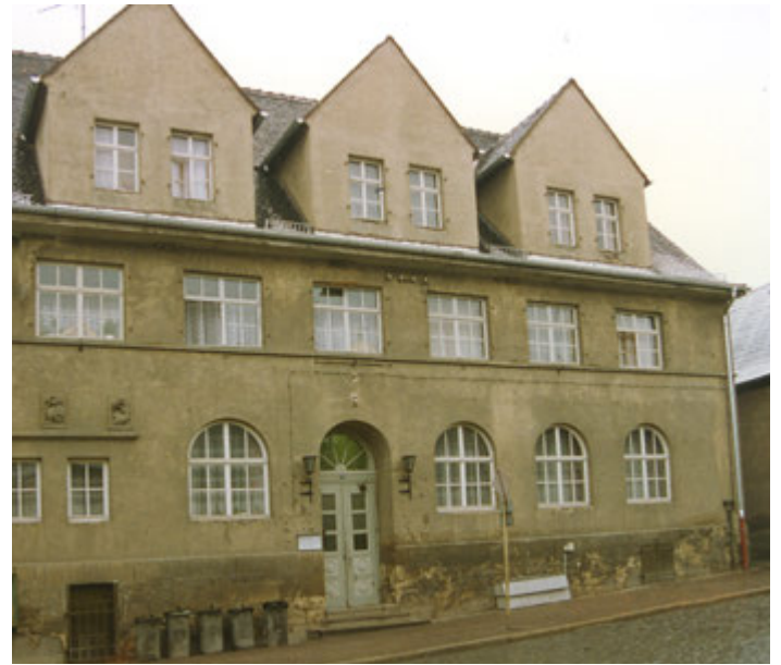
Zustand 1992 vor der Sanierung
