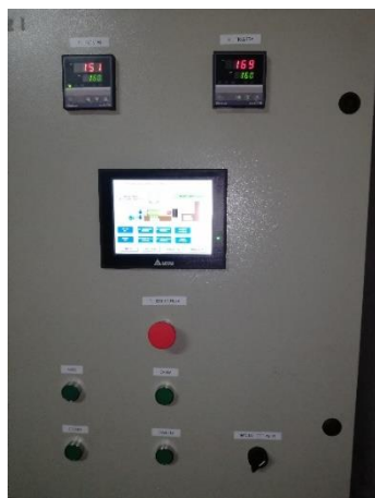
a) Parte externa del Tablero
