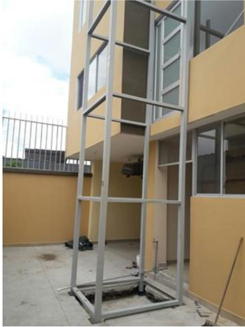
Fotografía 6. Montaje e instalación de la estructura en obra
