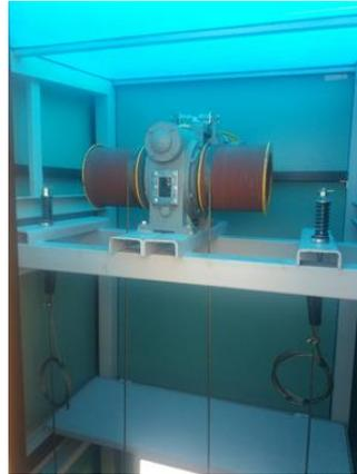
Figura 4. Equipo de tracción. Elaborado por: Fabricio Cadena y Diego Pineda
