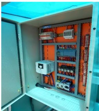
Figura 14. Tablero de control eléctrico. Elaborado por: Fabricio Cadena y Diego Pineda
