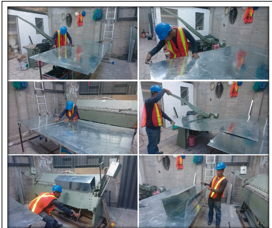
Figura 3. Trazo, corte y conformación del ducto.
