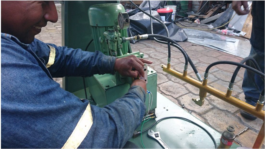
Instalación de la unidad hidráulica.
