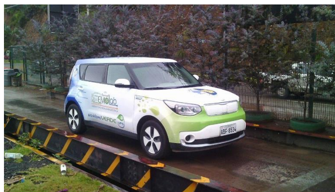
Figura 7: Balanza de puente para el pesado de los vehículos.
