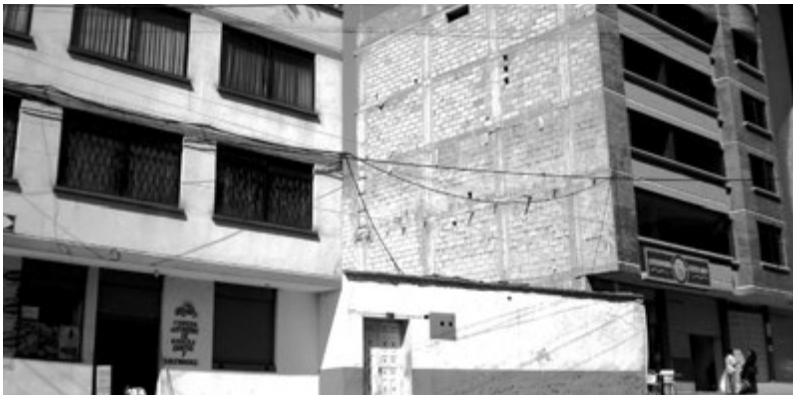
Casa intermedia del Sr. Casimiro Puma, pintor de casas y albañil. Natural de La Magdalena.
