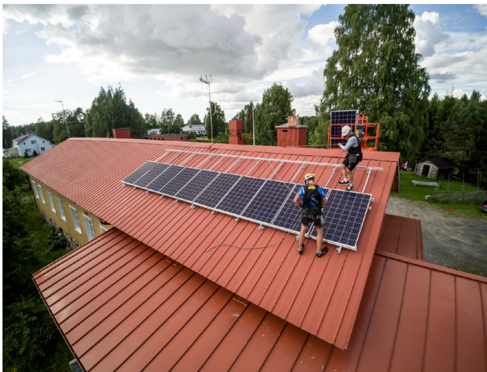
Kuva II: Aurinkopaneelien asennus Haikolan talolle. Kuva: Mikko Tirkkonen
