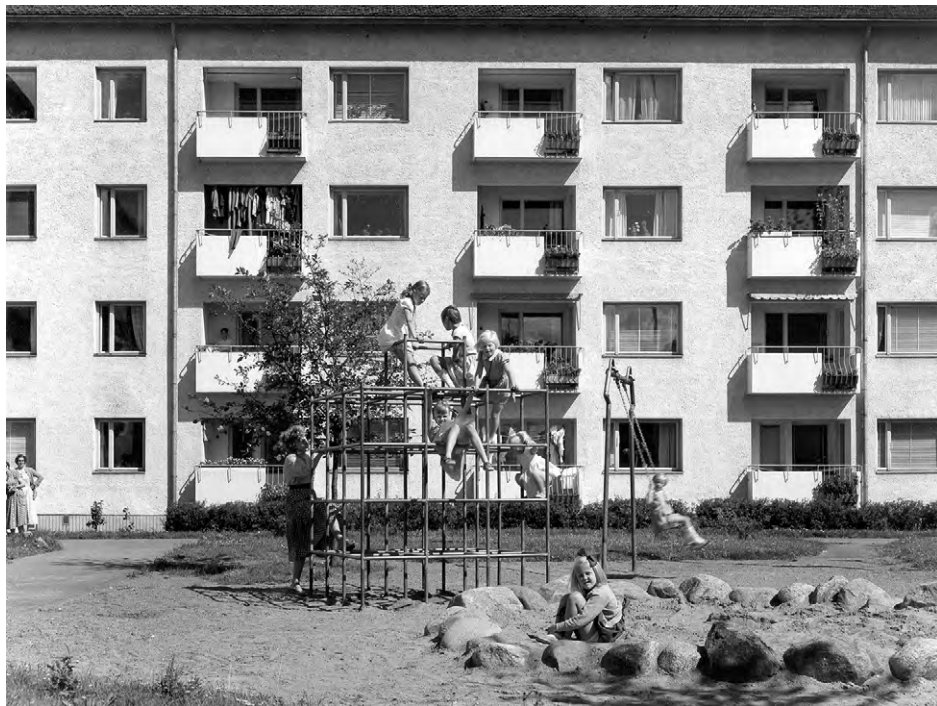
Kerrostalo-piha 1950-luvun lopulla Kisakylässä Helsingin Koskelantiellä. Olympiavuonna 1952 valmistuneiden kortteleiden väljillä pihoidilla oli varattu paljon tilaa lasten leikeille. Kuva: Heikki Havas, Helsingin kaupunginmuseo.
