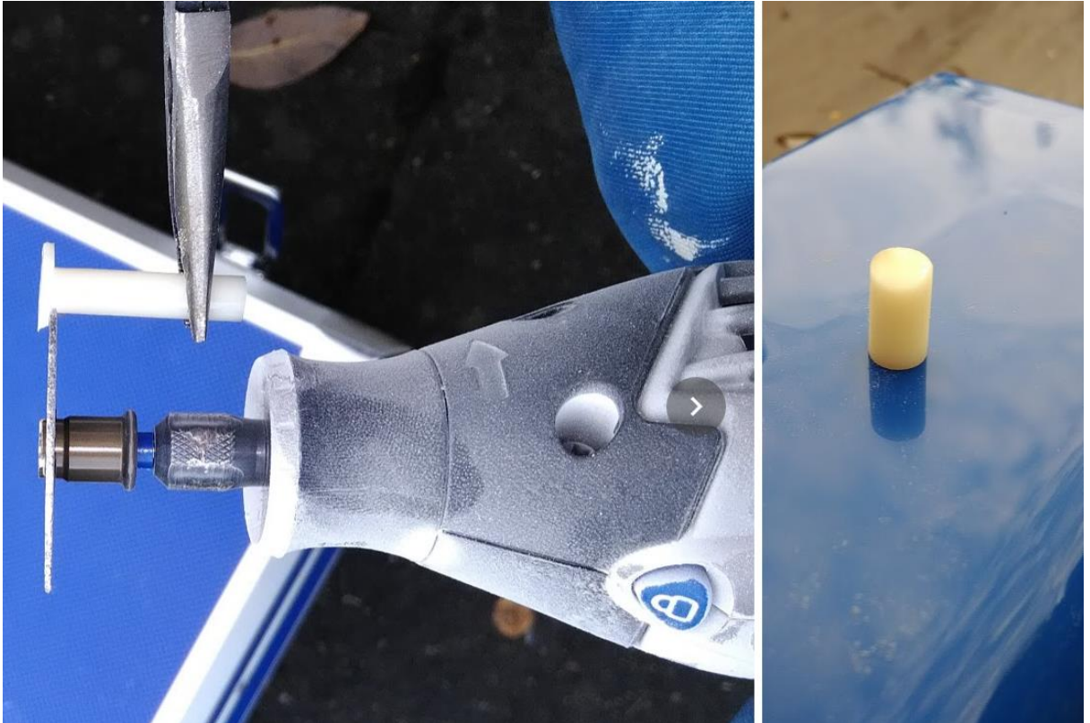
Kuva 22. Tukirakenteessa olevat putket voidaan leikata turvallisesti pitämällä tukevaa otetta pihdeistä. Oikealla leikatun putken pinta vaikuttaa silmännähdessä tasaiselta ja suoralta.
