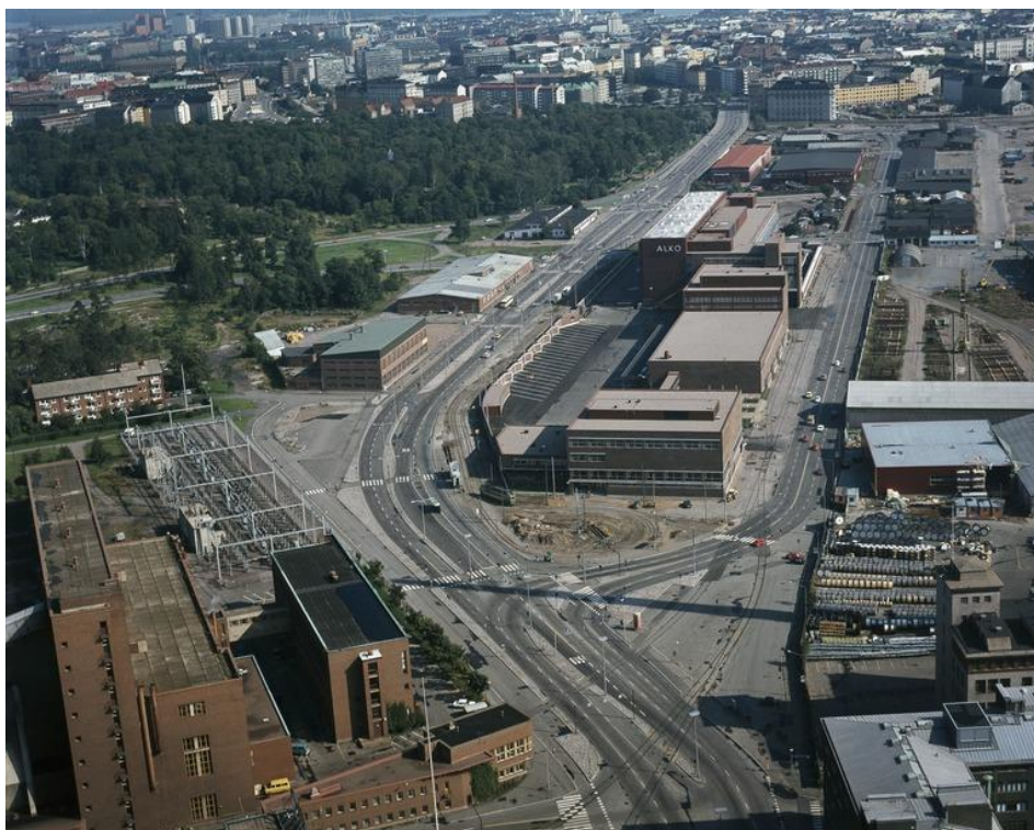
Kuva 223. Ruoholahden teollisuusalueetta vuonna 1978 Sky-Foton valokuvassa. Moni kuvan rakennuksista säilytettiin Ruoholahtea ja Salmisaarta rakennettaessa. (Finna.fi).
