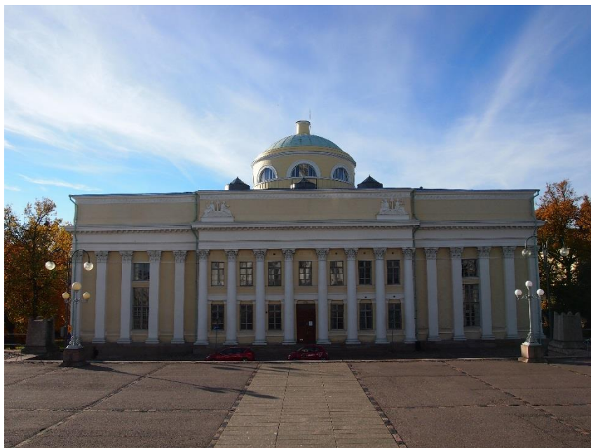
Kuva 20. Yliopiston kirjaston tilarakenne on peräisin Rooman Diocletianuksen kylpylästä ja myös ulkoasun arkkitehtuuri viittaa Roomaan – ja Pietariin. Katto on palladiolainen. (Miika Norppa).
