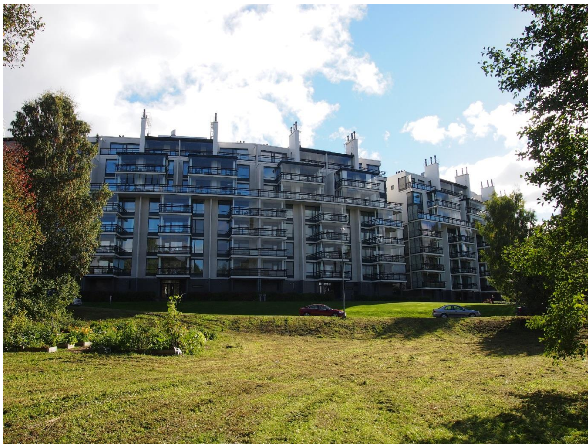
Kuva 256. Arvokasta asuntorakentamista meri- ja puistomaisemissa Töölön Kesäkadulla. (Miika Norppa).
