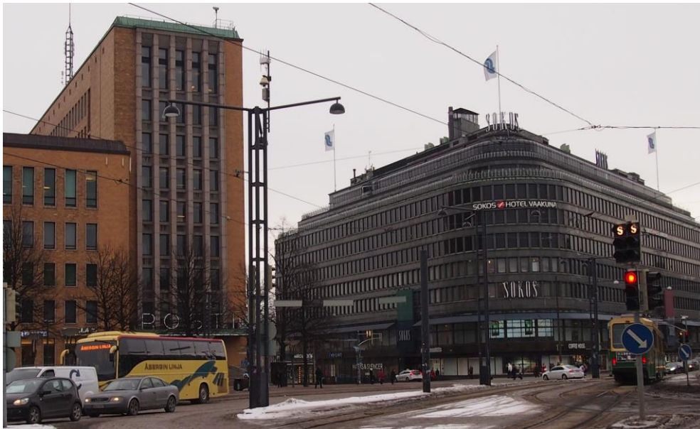
Kuva 168. Postitalo (1938) ja Sokoksen tavaratalo (1952) ja edustavat funktionalismia. Rakennukset keskustelevat keskenään toisistaan poikkeavin muodoin. (Miika Norppa).
