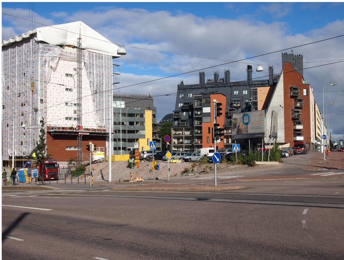
Kuva 255. Töölön Stage -kortteli rakentumassa Leppäsuolla. (Miika Norppa).
