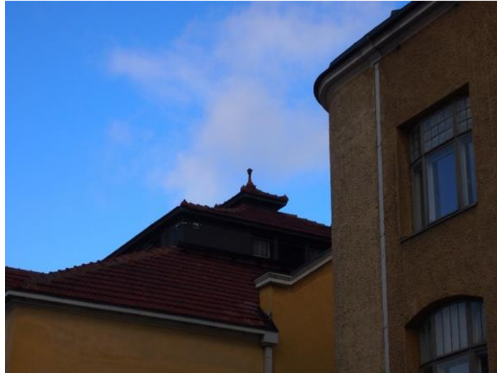
Kuva 65. Siltavuorenpenger 20 M:n katto on japanilaisvaikutteinen. (Miika Norppa).
