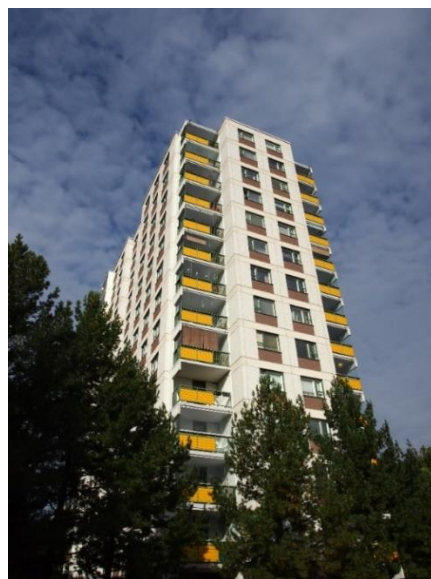
Kuva 190. Itä-Pasilan tornitorakentamista. Arkkitehtonisesti alue ei toteutunut esikuviensa veroisena. (Miika Norppa).
