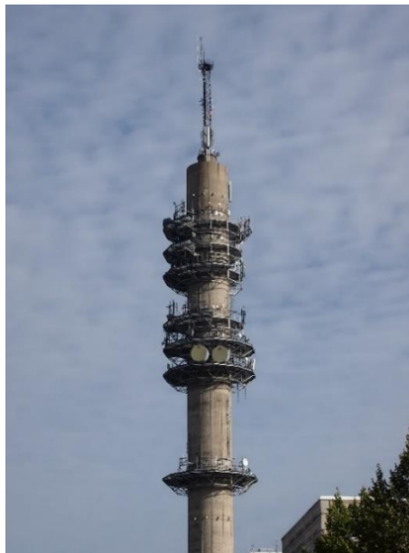
Kuva 212. Ilmalan betonibrutalistinen linkkitorni. (Miika Norppa).
