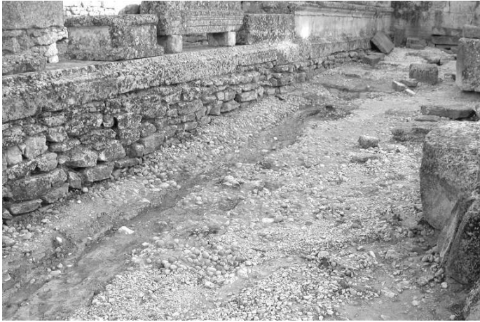
■ 2 Vue de la zone ravinée par les pluies torrentielles, devant le portique dorique de Glanum. On distingue parfaitement le sol de petits galets interrompu par le creusement de la tranchée de fondation du second état du portique dorique (cliché J.-L. P.).
