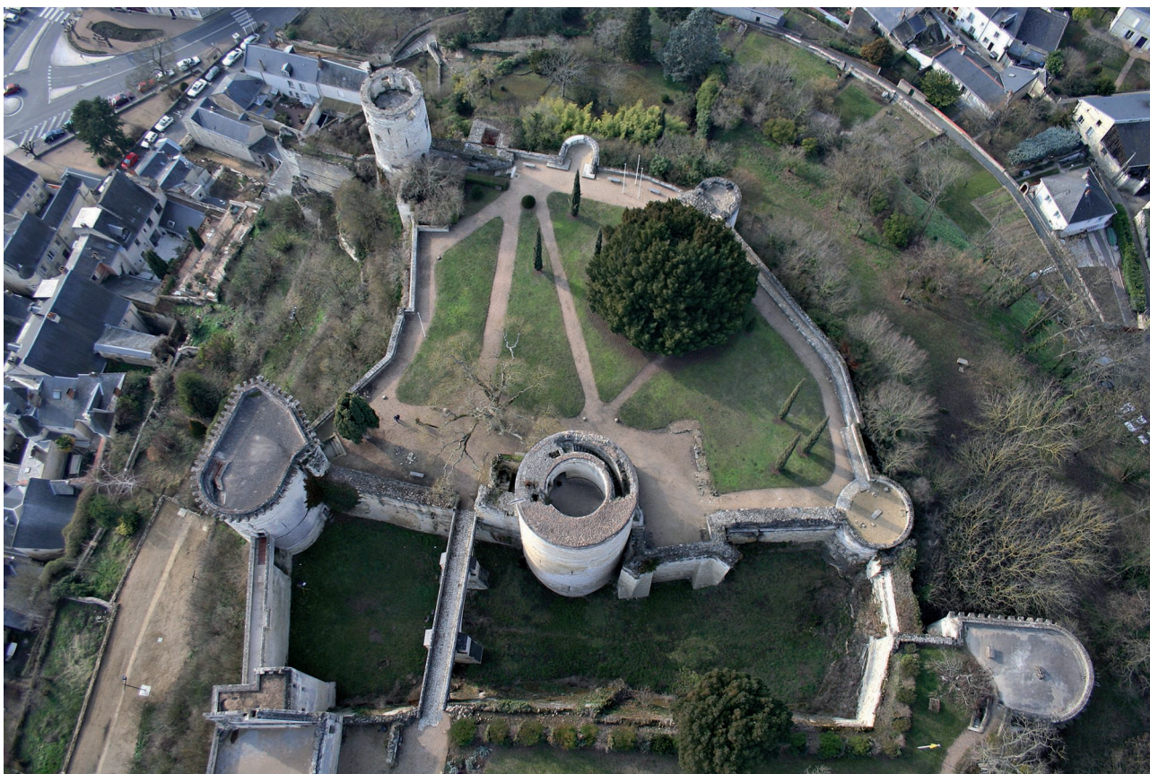
Fig. 3 : Vue oblique de la douve séparant le château dit " du Milieu " et le fort du Coudray. Au premier plan, une partie des logis royaux, remontant au XII e siècle et très remaniés pour le séjour du roi de France Charles VII, lorsqu'il avait fait de Chinon un des principaux lieux de résidence de la cour (Photo Cyb'Air, droits réservés pour le Conseil Général d'Indre-et-Loire).
