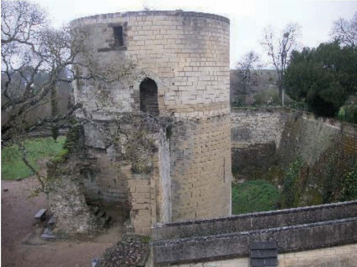
Fig. 5 : Vue de la tour du Coudray depuis le sud-est ; au premier plan, le pont qui franchit la douve séparant le château du Milieu du fort du Coudray.
