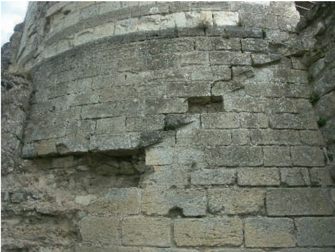
Fig. 9 : Les traces de l'escalier qui s'enroule le long du donjon.
