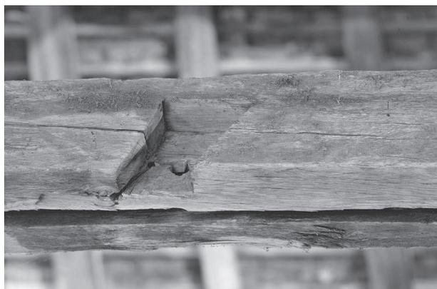
Fig. 7. Cellier, dortoir des conves, charpente, pièces avec mortaises à tiers-bois et rainures.
