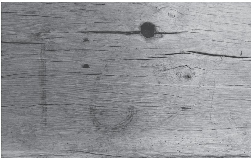
**Fig. 27.** Cellier, dortoir des convers, charpente, ferme V, millésime 169[8].
