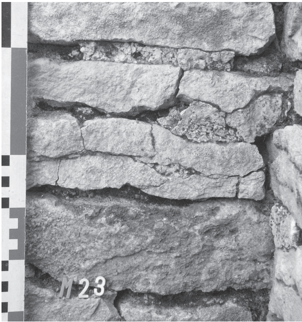
Fig. 10. Restes de joints regarnis à l'angle des murs M023 et M024 (photo A. Coutelas).
