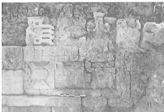
FIG. 2 – En la fachada norte del edificio con torres del Grupo A de Río Bec, paneles decorados en proceso de liberación (desde arriba hacia abajo, Panel I, Panel II y Panel III)
