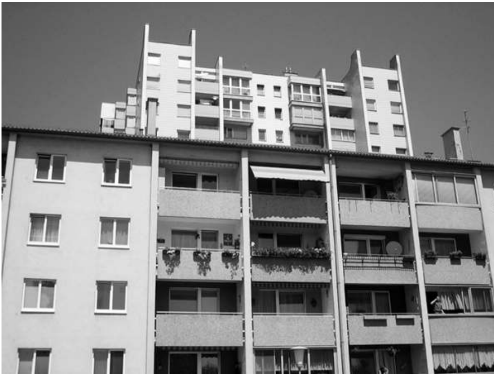
Photo 1 : Immeubles d'habitation à étages à Korneuburg.
