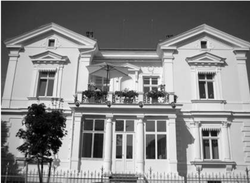
Photo 3 : Bâti ancien, rénové à Mödling.
