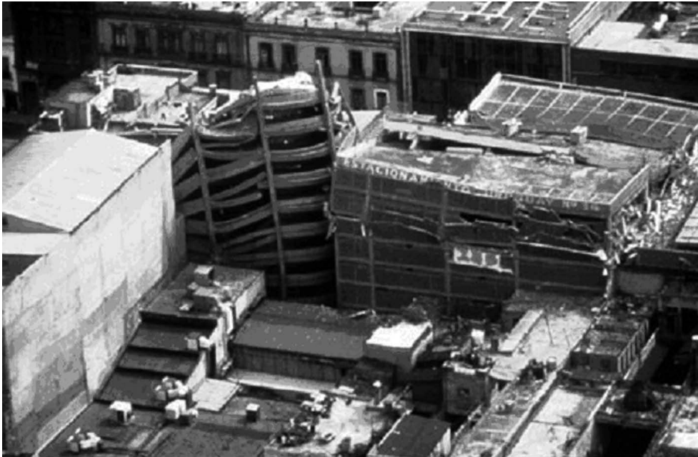
Photo 1. Séisme de 1985 à Mexico : effondrement vertical d'un immeuble.
