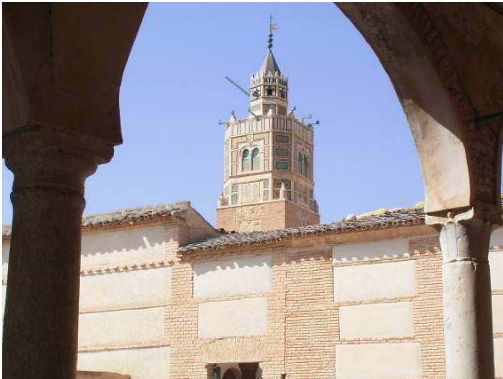
Figure 4. La Grande Mosquée de Testour : superposition du plan octogonal au plan carré
