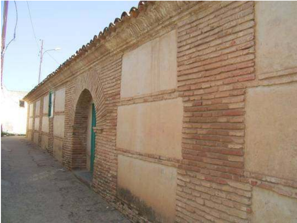
Figure 5. Arases et chaînages de briques dans l'ancienne médina de Testour
