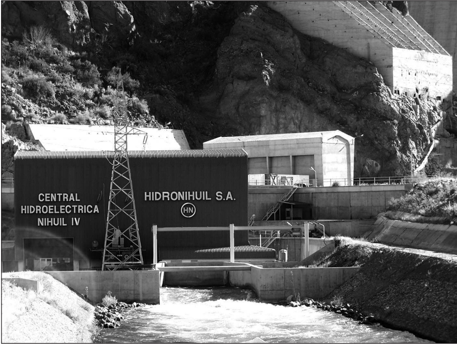
Photo 5. – La centrale de Nihuil IV dans les gorges de l'Atuel.
