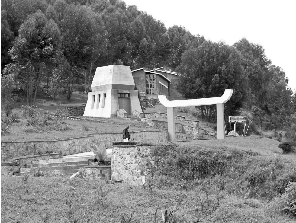
Fig. 2 Site de Biseseo : à l'entrée du site se dresse un monument symbole de résistance et trois bâtiments comprenant chacun trois pièces destinées à conserver les preuves du génocide de 1994. Les trois bâtiments rappellent les trois collines d'où sont venues les victimes. Le passage les reliant entre eux évoque le chemin de Golgotha. Photo : C.K.M.
