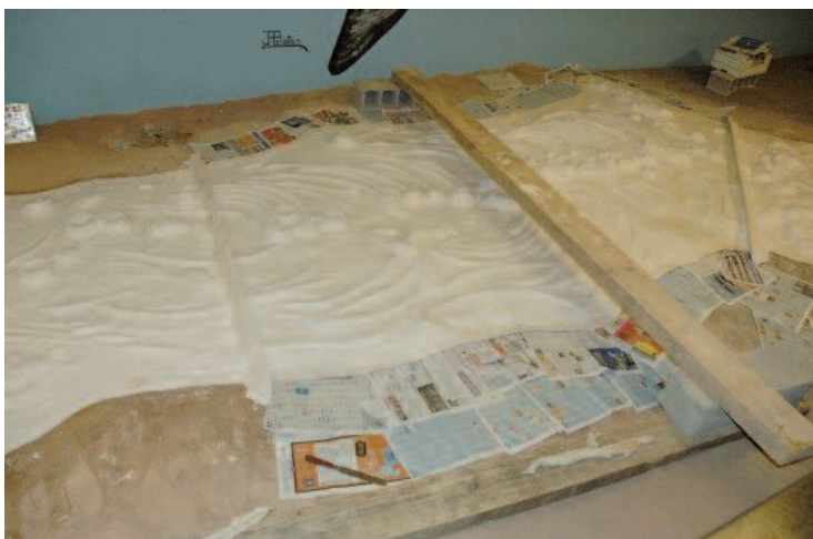
Construction des deux murailles sur la membrane en silicone © T. Contucci
