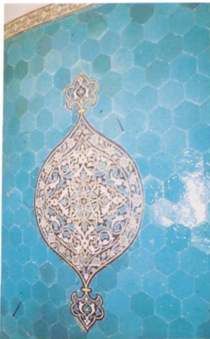
M. B.-T. Fig. 5 : Bursa, intérieur du Turbé Vert. Détail de la décoration des murs, p. 255.
