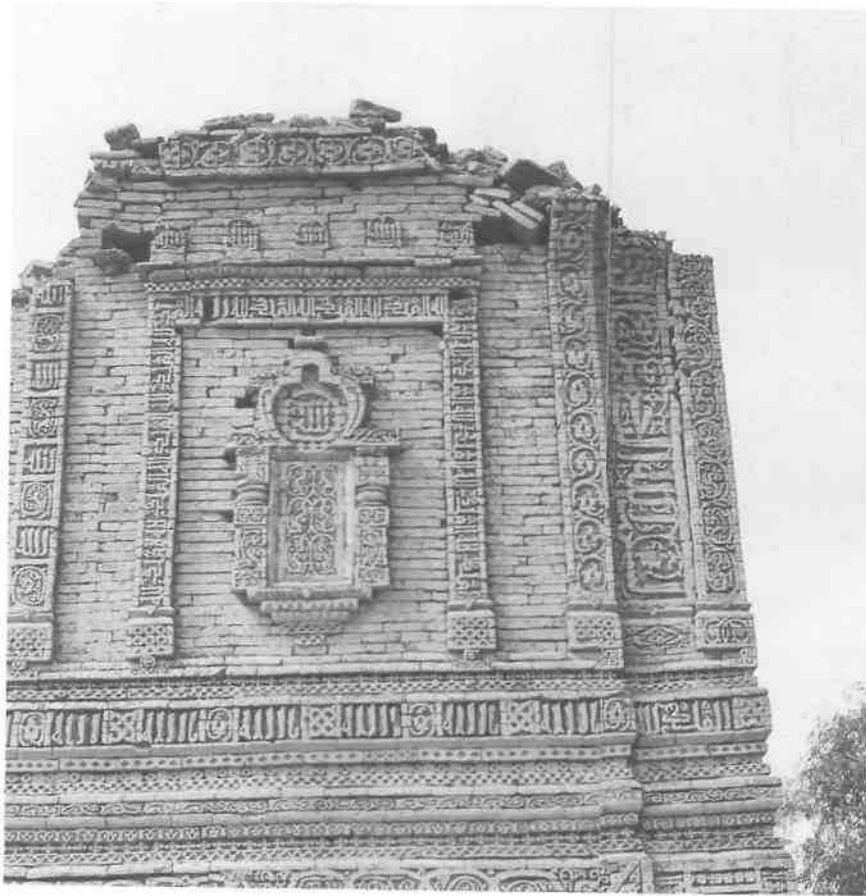
Fig. 21. Partie droite de la façade ouest, façade portant des inscriptions.
