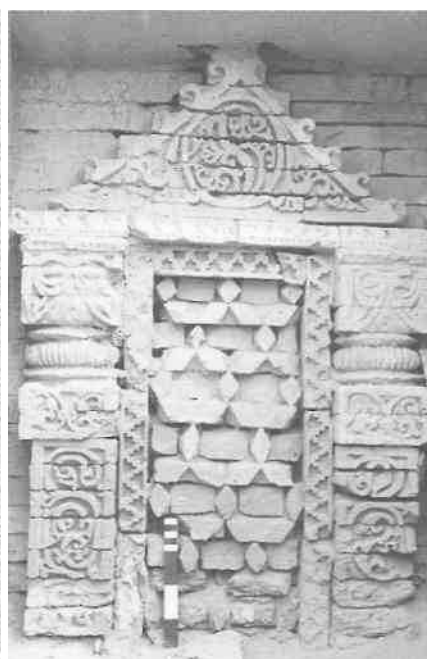
Fig. 20. Fausse fenêtre décorative du soubassement.
