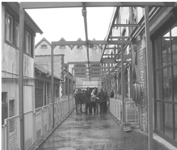
Des stagiaires visitent le patrimoine textile troyen réhabilité (photo GDF)
