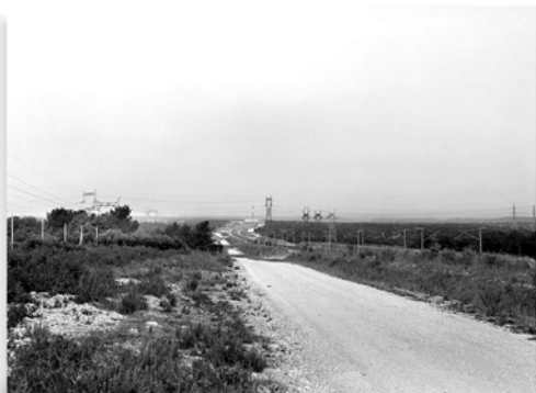
▲ Figure 26. Cabriès (Bouches-du-Rhône), chantier TGV, février 2002. © A. Ceccaroli.
