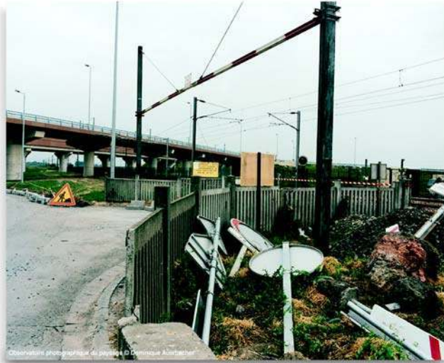
▲ Figure 14. Nord-Pas-de-Calais, Seclin, D 925 et ligne TGV, à droite le chemin de fer régional, septembre 1993. © D. Auerbacher.
