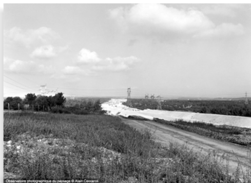
▲ Figure 24. Cabriès (Bouches-du-Rhône), chantier TGV, mars 1998. © A. Ceccaroli.
