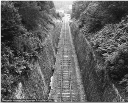
◀ Figure 16. Viaduc de Marlange, août 1997. © A.-M. Filaire.
