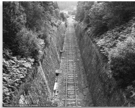
Figure 17. ▶ Viaduc de Marlange, août 1999. © A.-M. Filaire.
