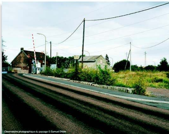
▲ Figure 13. Noyelles Godault/Courcelles. Passage à niveau entre Noyelles Godault et Courcelles, septembre 1995. © S. Dhôte.
