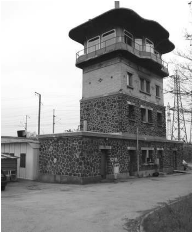
Figure 12b, le poste d'aiguillage du triangle de Gagny, Grande Ceinture.
