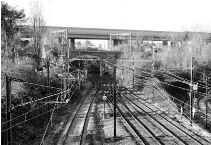
Figure 13b : Noisy-le-Sec - Passage des voies impaires Paris-Meaux sous la Grande Ceinture (ordinaire et complémentaire) et l'autoroute A3. Photo prise en direction de Paris depuis le pont de l'avenue Jules-Ferry à Bondy.
