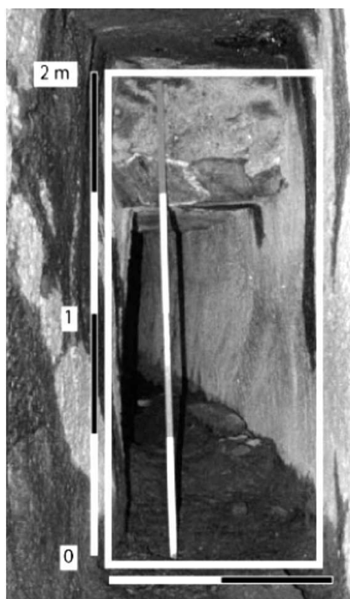
Figure 3 : (Voir planche couleur) Détail de la galerie romaine de La Ratéria, supposée être une chasse hydraulique destinée à une probable exploitation métallurgique située dans le vallon du Châtelard; cl. J. Serralongue, 1994.
