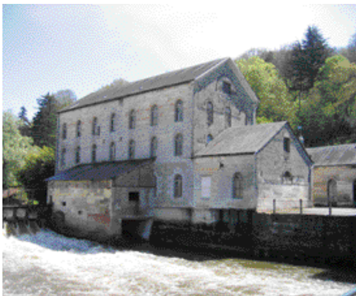
Ancienne filature de Crousilles construite vers 1830, La Chartre-sur-le-Loir © Louis André
