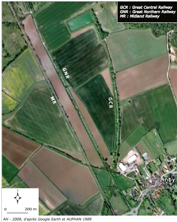
Figure 2 – Nottingham-Mansfield : l'enchevêtrement des trois voies ferrées au nord de Hucknall La cohabitation sur le terrain de ces trois infrastructures ferrées redondantes, installées dans un faisceau de quelques centaines de mètres à peine, illustre le libéralisme, l'absence de planification du réseau par l'Etat et son laissez-faire qui ont caractérisé la constitution du réseau ferré britannique.
