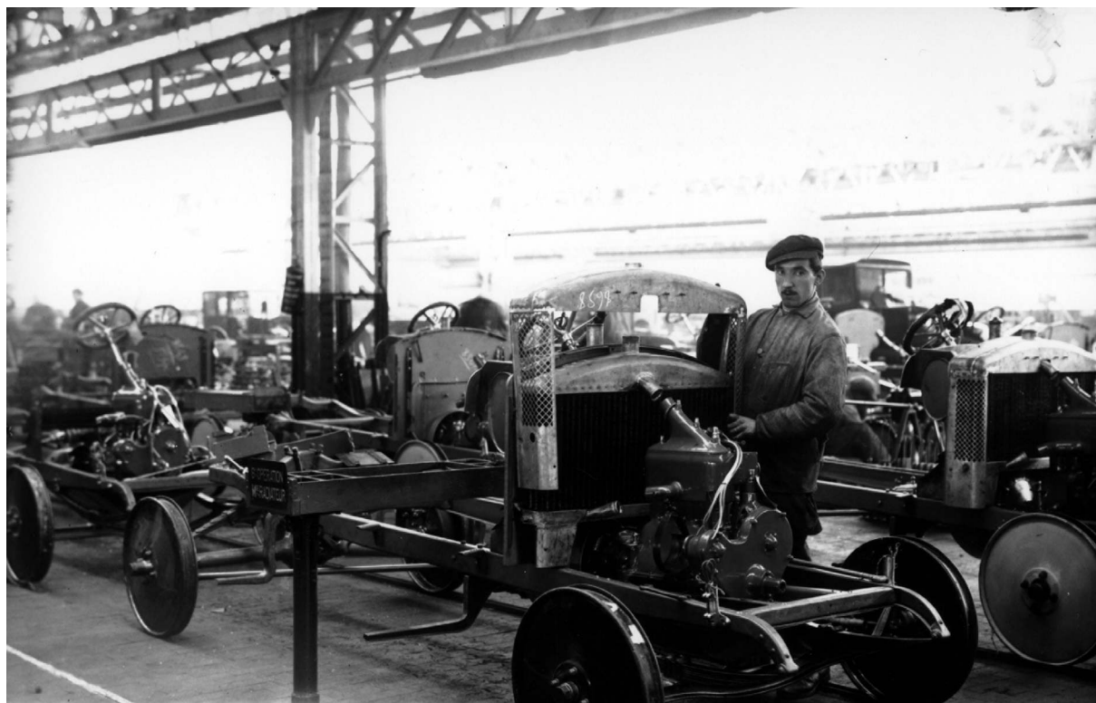
fig. 5 - Photographies de la pose radiateur dans l'atelier C5 : 6 e opération (1922) - Source : photos Renault Communication / droits réservés.
