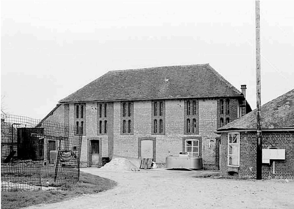
Vieux-Pont, Le Bôquet. Elévation ouest du hâloir Phot. Inv. P. Corbierre © Inventaire général, ADAGP, 1995
