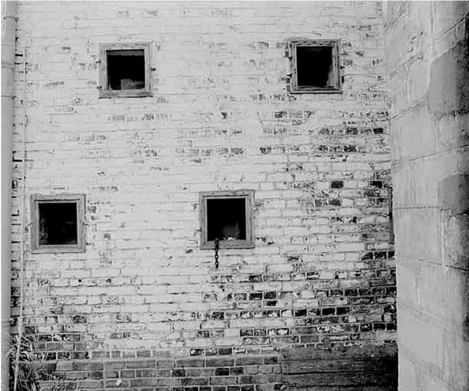
Orbec, Beauvoir. Détail des ouvertures d'un hâloir à livarots Phot. Inv. F. Decaëns © Inventaire général, ADAGP, 1996
