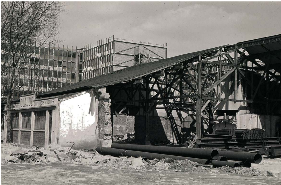
Archives de Paris Diderot, série Ph (ph 6-5) « Faculté des sciences : destruction de la Halle aux Vins, construction de Jussieu » par M. Pascal (1964-1969).
