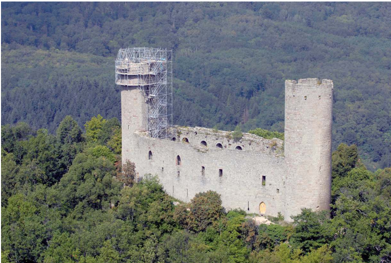
Vue aérienne des travaux du château d'Andlau, 2006.
