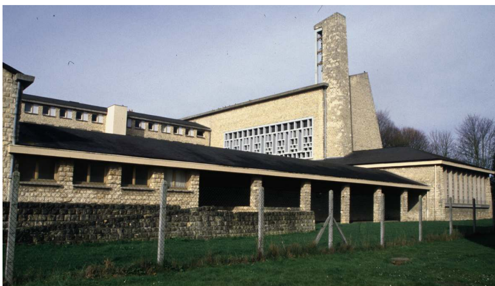
Vue du monastère depuis l'est. Au premier plan, le préau couvert qui s'appuie contre la galerie orientale du cloître. Phot. Alain Nafilyan.
