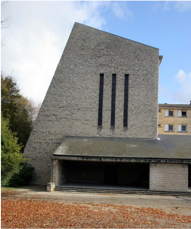
Élévation de la façade ouest de l'église abbatiale. Phot. Alain Nafilyan. © CRMH Basse-Normandie.
