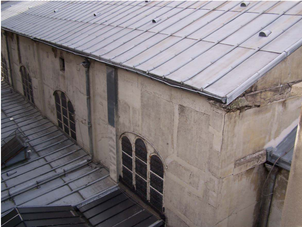
Saint-Martin des Marais (10e arr.). Maçonneries extérieures en pan de bois. Phot. Laurence Fouqueray.
