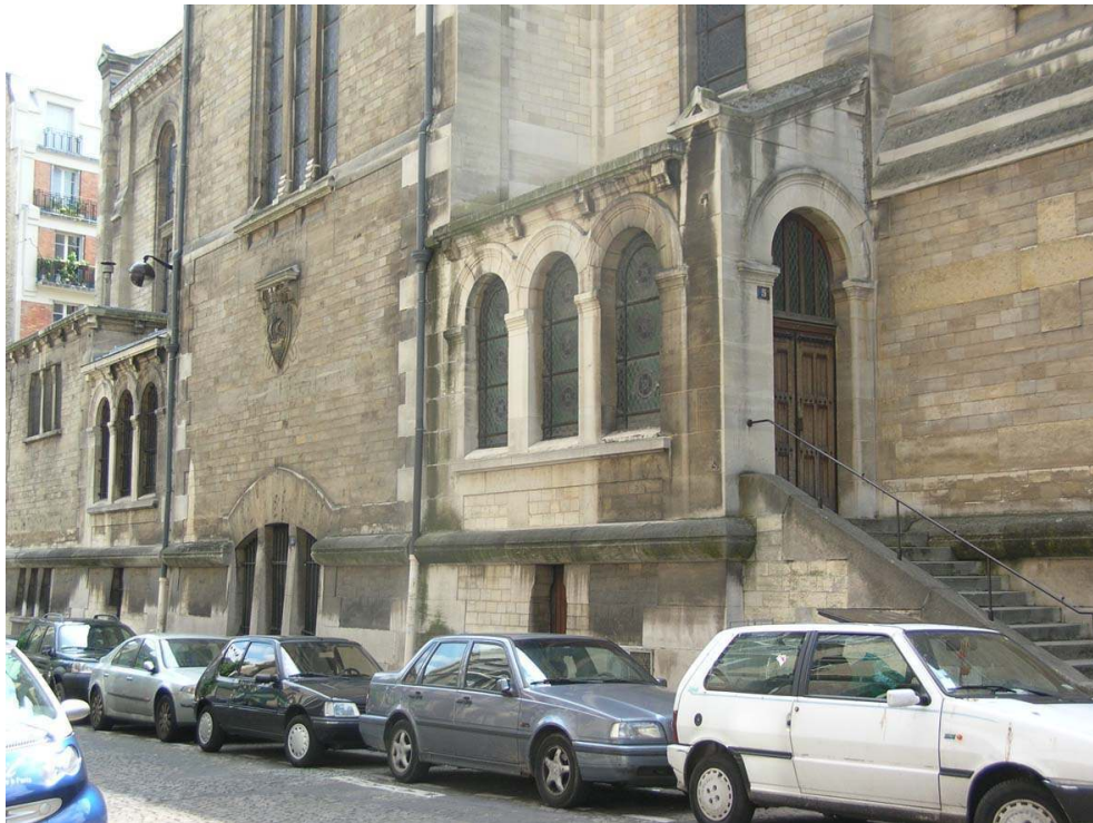
Notre-Dame d'Auteuil. L'étagement des volumes permet l'insertion de locaux d'accueil et de bureaux paroissiaux. Phot. Laurence Fouqueray.
