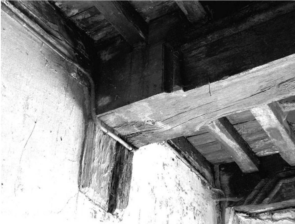
Vraincourt (Meuse). Plancher à poutres posées sur poteaux à corbeau (XVI e -XVII e siècle) Ferraresso, Ivan © Université Nancy 2, 2006
