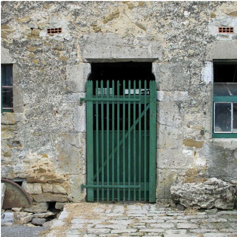
Pleuvezain (Vosges). Montage structuré d'une porte d'écurie à linteau sur coussinets Ferraresso, Ivan © Université Nancy 2, 2006
