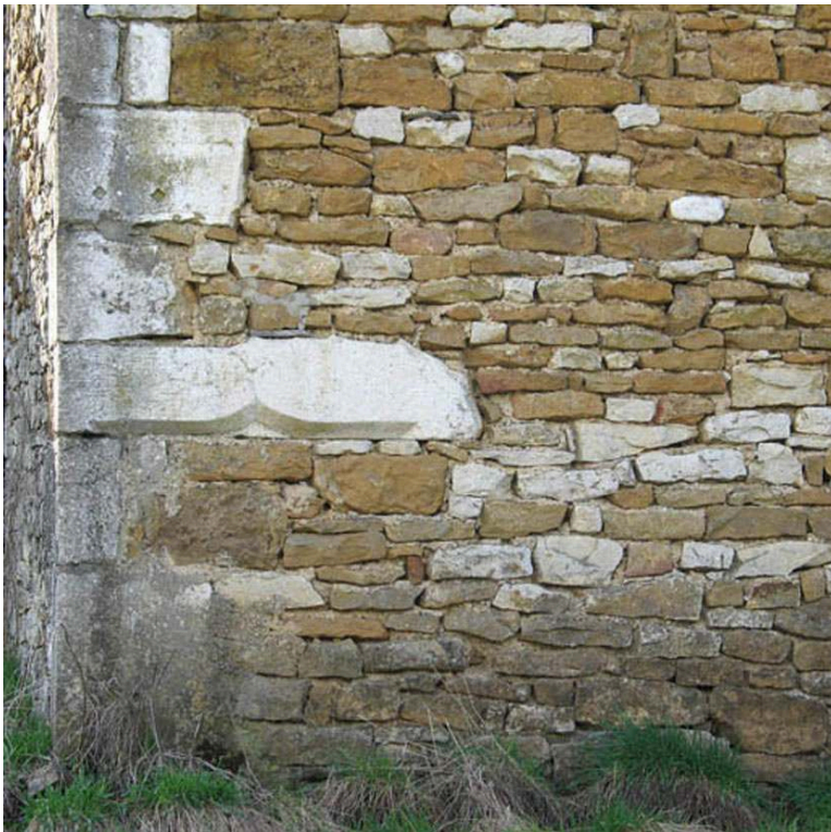
Tramont-Lassus (Meurthe-et-Moselle). Remploi en chaîne d'angle d'un linteau à décor d'accolade sur chanfrein
