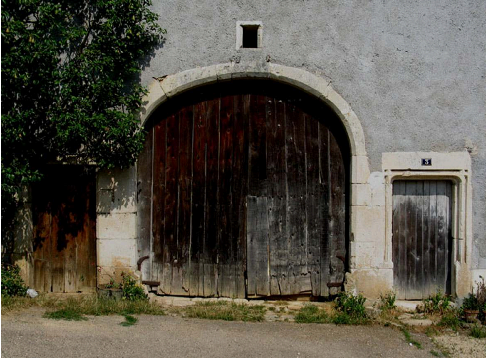
Thuilley-aux-Groseilles (Meurthe-et-Moselle). Montage structuré d'un portail composé d'une porte piétonne de logis, une porte charretière et une porte d'écurie Ferraresso, Ivan © Université Nancy 2, 2006
