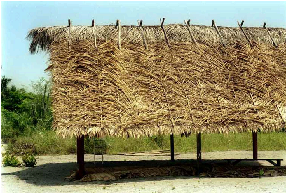
Carbet couvert en wai, avec des feuilles de malipa rapportées en surface, pour l'étanchéité Phot. Inv. MB. Potte © Inventaire général, ADAGP, 2002
