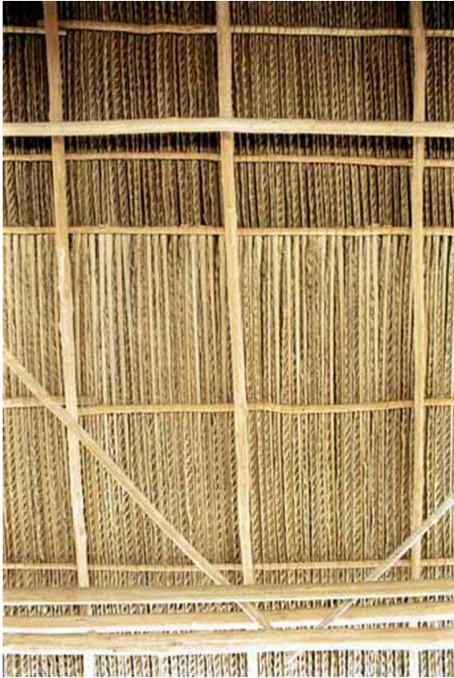
Détail du tissage en wasai de la couverture d'un carbet, Awala Phot. Inv. MB. Potte © Inventaire général, ADAGP, 2002
