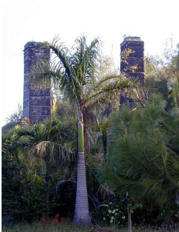
Saint-Joseph. Usine Langevin, cheminée à chaînage horizontal et vertical en bois Phot. Inv. E. Zeimert © Inventaire général, ADAGP, 1996
