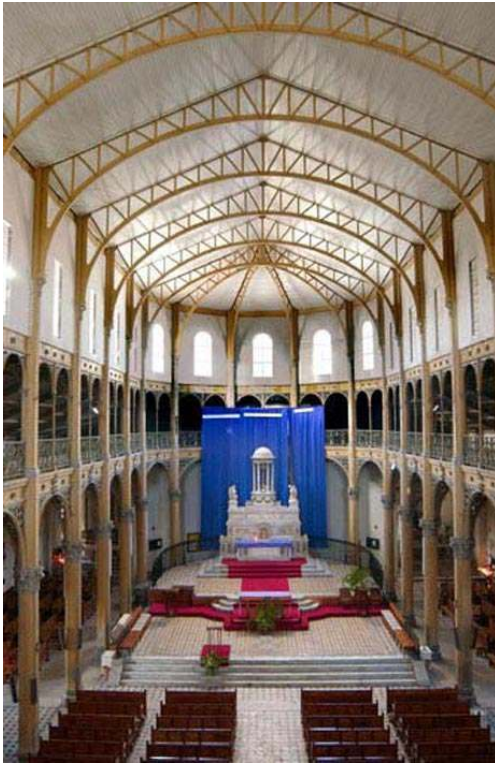
Eglise Saint-Pierre et Saint-Paul. Vue de la nef centrale et la structure métallique. Phot. Inv. J.-F. Peiré © Inventaire général, ADAGP, 2002.
