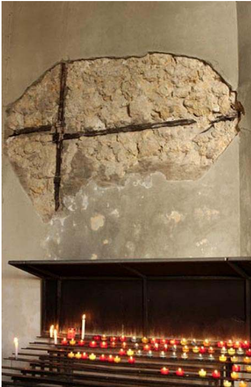
Eglise Saint-Pierre et Saint-Paul. Détail du pan de fer noyé dans la maçonnerie des murs. Phot. Inv. J.-F. Peiré © Inventaire général, ADAGP, 2004.
