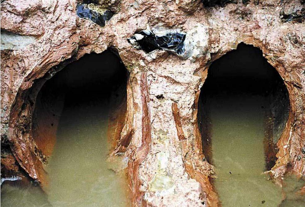
Canalisations en terre cuite de l'aqueduc, d'un diamètre de 19 cm, enrobé dans un lit de ciment dit romain, découvertes lors de travaux de construction d'une villa
