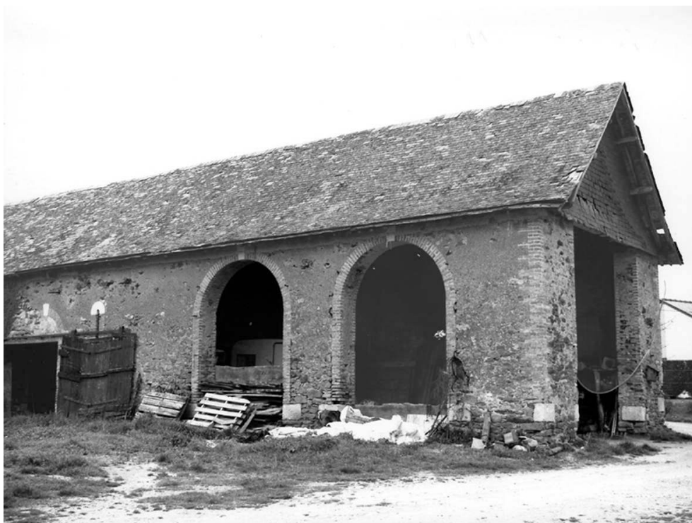
Chauvon (Le Lion-d'Angers), hangar avec larges baies encadrées de brique. Manase, Viviane © ADAGP/Conseil général de Maine-et-Loire, 1999.
