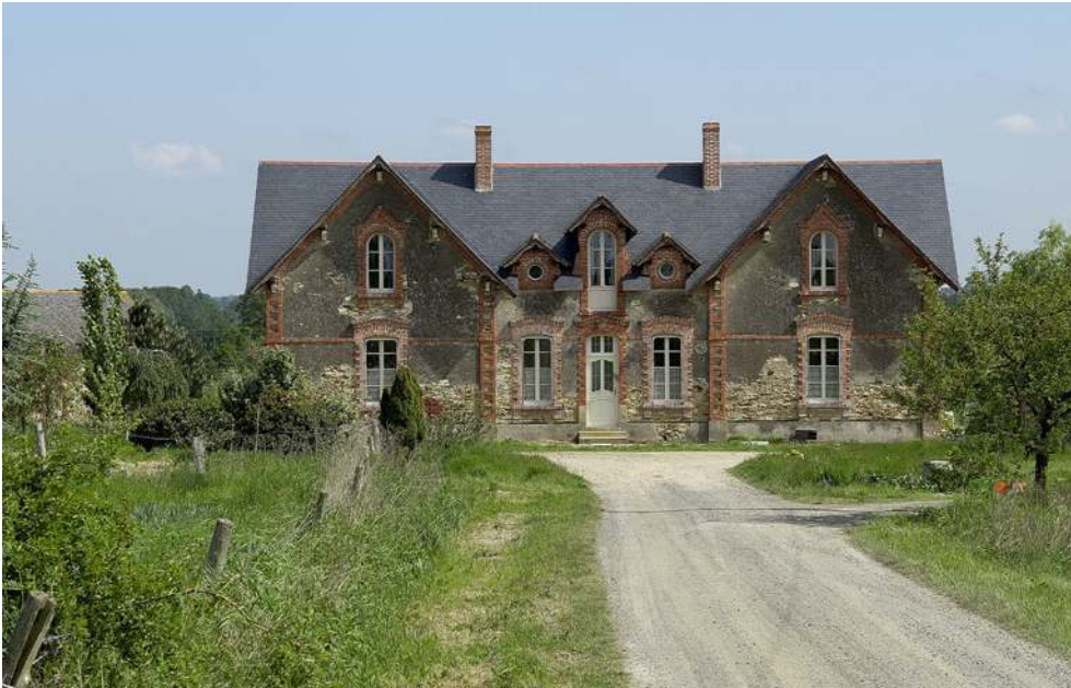
La Courtière (Le Lion-d'Angers), façade principale du logis. Rousseau, Bruno © ADAGP/Conseil général de Maine-et-Loire, 2005.
