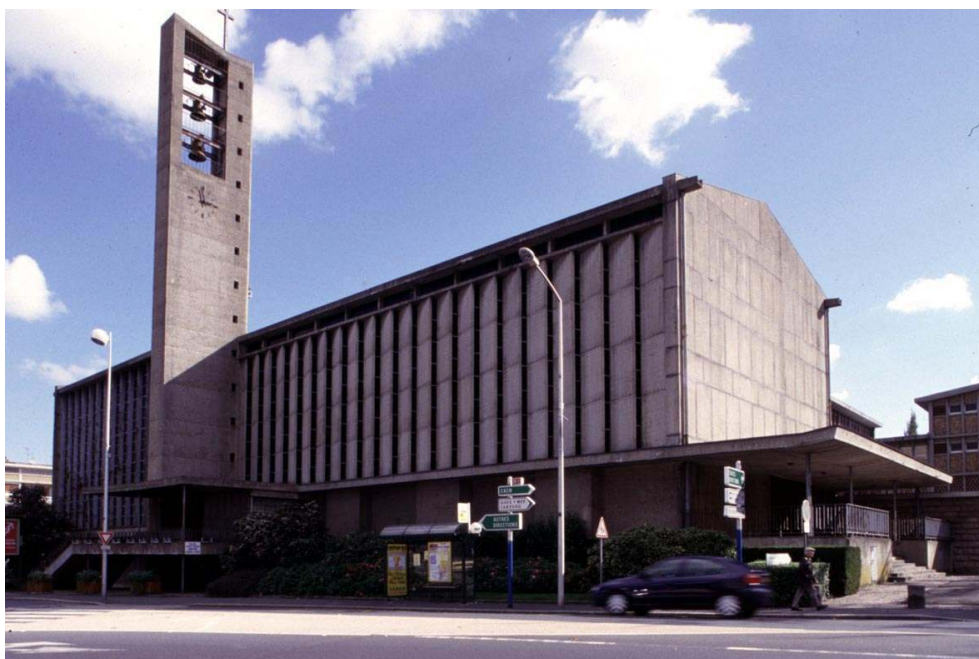
Élévation nord de l'église Saint-Désir de Lisieux (Calvados)
