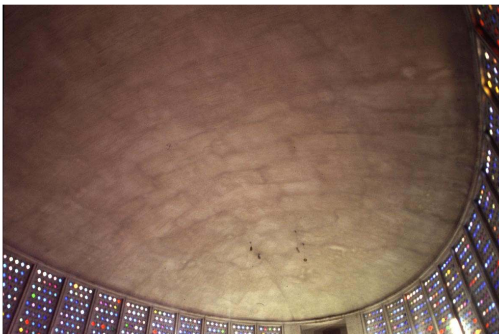
Vue de la voûte elliptique de l'église Saint-Julien de Caen Phot. Alain Nafilyan. © CRMH Basse-Normandie
