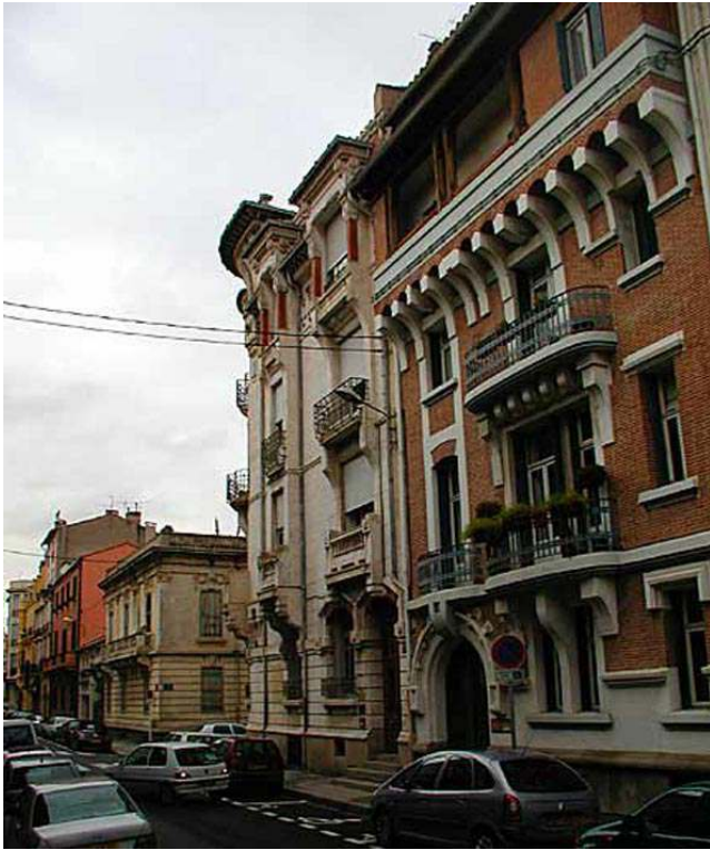
Lotissement des Remparts Nord. Immeubles, rue Jeanne-d'Arc. De droite à gauche : n° 13 par Henri Sicart (1914, surélevé en 1925), n° 11 par Claudius Trenet (1906 ?) et n° 9bis par Louis Trenet (1924) Phot. Inv. T. Lochard © Inventaire général, ADAGP, 2003
