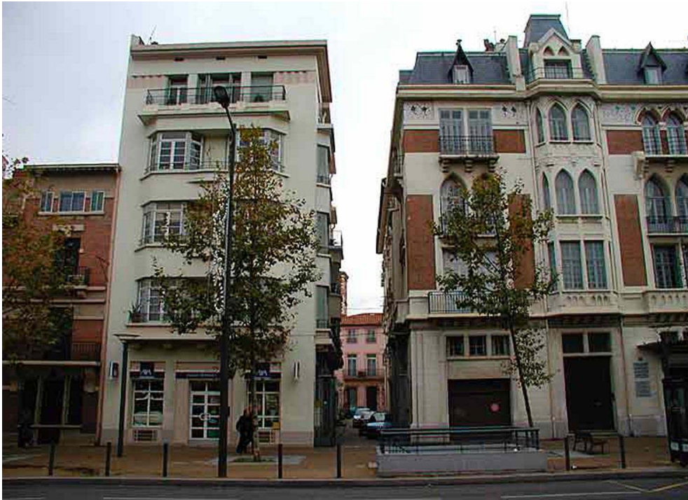
Lotissement des Remparts Nord. Immeubles, boulevard Wilson. A gauche, n° 10 par [Louis ?] Trenet (1932) ; à droite, n° 8 par Henri Sicart (1920)
