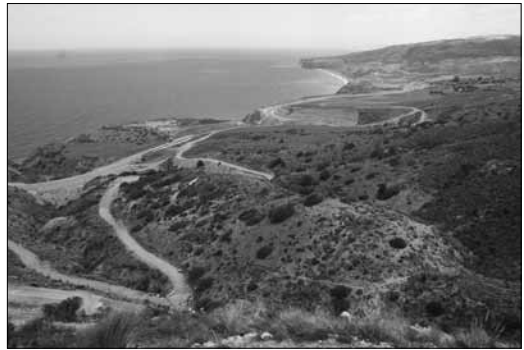
Photos 3 et 4 : La rocade, creusée dans les plates-formes littorales et traversant les oueds remblayés (clichés E. G., 2006 et 2007)
