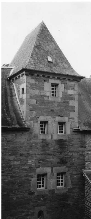
Photo XIX : Maison Penanault à Morlaix : association du granite en pierres de taille au schiste en moellons.
