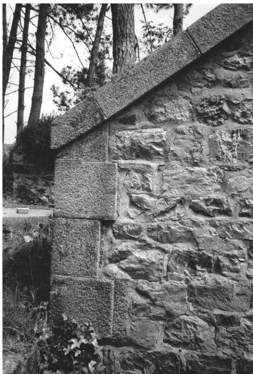
Photo II : Batterie du Kador à Crozon : le grès armoricain, utilisé en moellons, ne permet pas l'obtention de pierres de taille, d'où appel au granite de l'Aber-Ildut pour les chaînages d'angles et rampants.
