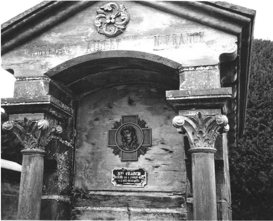
Photo XVII : Au cimetière de Nozay, tombe-chapelle en schiste local, y compris les colonnettes cylindriques et les chapiteaux finement ouvragés.
