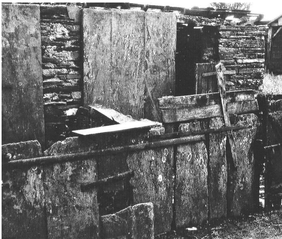
Photo XVI : Bâti en palis au Souchais (environs de Nozay, Loire-Atlantique). Photo XVI: Slate building at Le Souchais, near Nozay (Loire-Atlantique).
