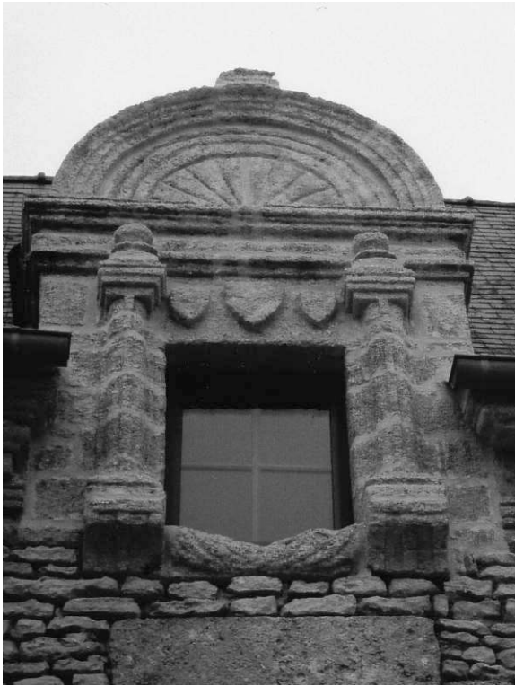
Photo XXXI : Le Marais (1668), à la sortie de Tréfumel : lucarne en « pierre de jauge ».
