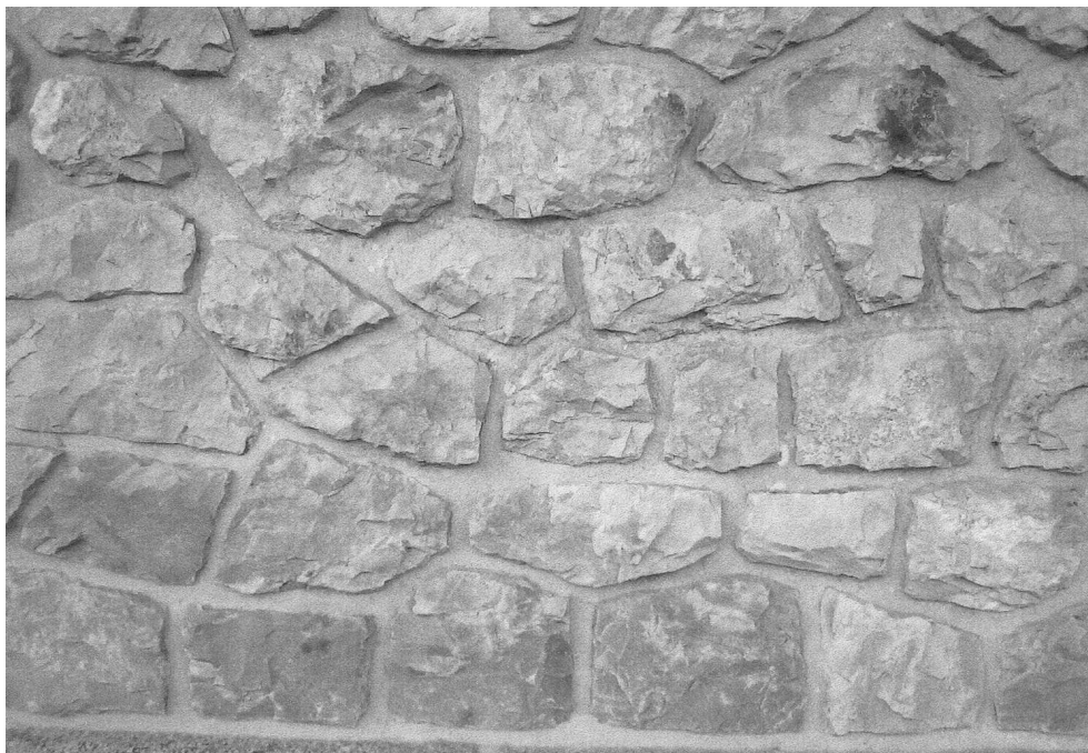
Photo III : Gare de Plomodiern : moellons en grès armoricain (l'appareil joue de leur irrégularité naturelle).
