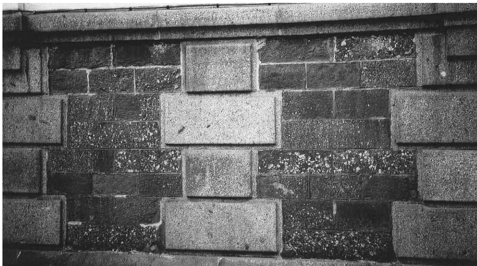
Photo XXI : Rennes, boulevard de La Liberté : poudingue de Montfort et schiste rouge associés à un granite clair du batholite mancellien.
