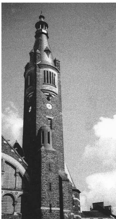
Photo X : Église Sainte-Jeanne-d'Arc à Rennes : schistes rouges associés au béton.
