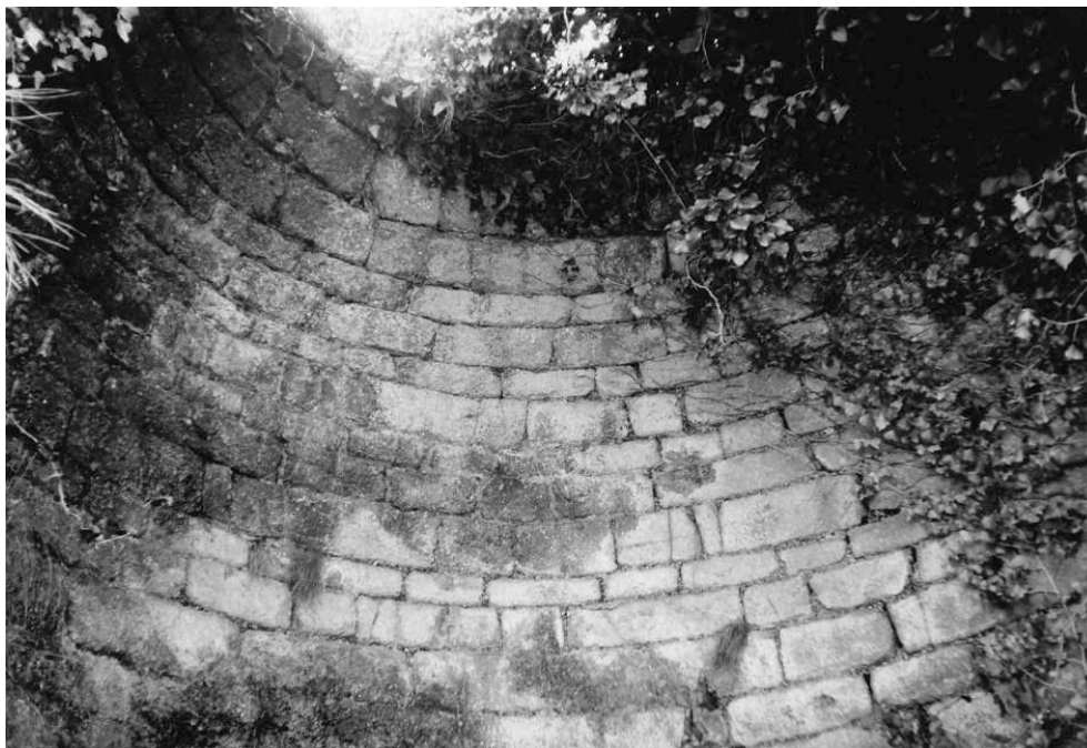
Photo XXVII : Intérieur du four à chaux de Postermen à Roscanvel (Finistère).
