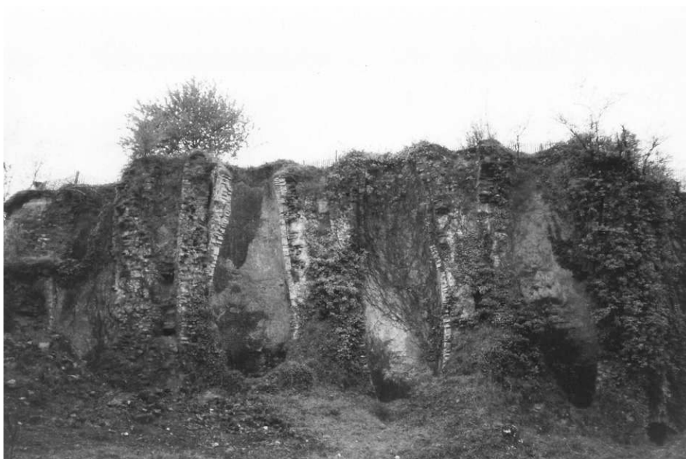
Photo XXVIII : Anciens fours à chaux éventrés à Chartres-de-Bretagne (Ille-et-Vilaine).
