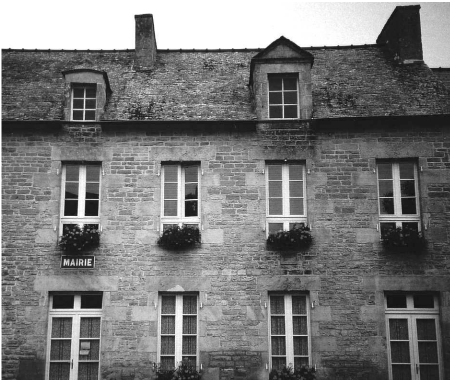
Photo XXXII : à Tréfumel, la mairie est aujourd'hui installée dans une belle demeure de 1768 qui fait un large appel au calcaire local, non seulement pour les moellons de l'élévation, mais aussi pour l'encadrement des ouvertures.
