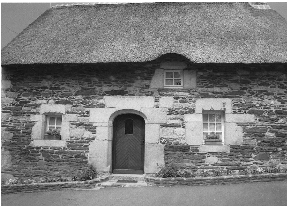
Photo XII : Saint-Nicolas-des-Eaux (Morbihan) : association de moellons en schiste bleu sombre à des pierres de taille en granite.
