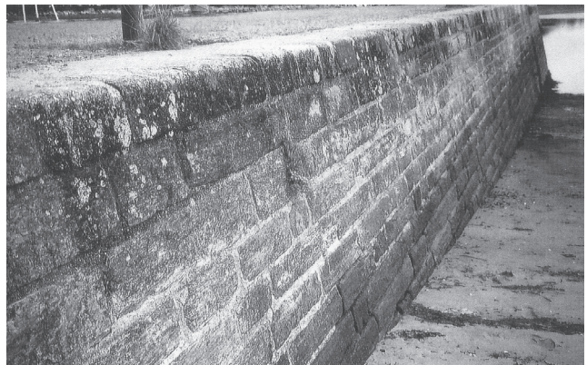
Photo XV : Vieux port de La Forêt-Fouesnant (Finistère) : le parement de la cale est en orthogneiss et la tablette en granite de Trégunc. Photo XV: Old port of La Forêt-Fouesnant (Finistère): slipway facing of orthogneiss and parapet coping of Trégunc granite.
