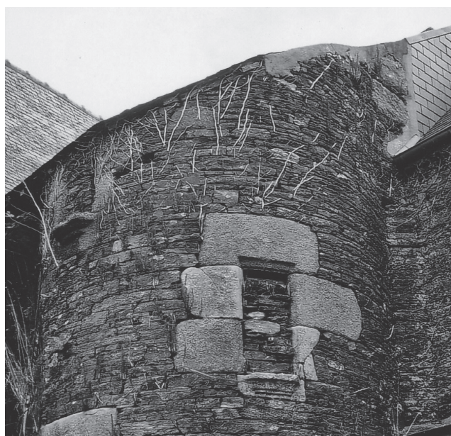
Photo III : Manoir de Coat-glaz à Henvic (Finistère) : moellons micaschisteux et pierres de taille granitiques.
