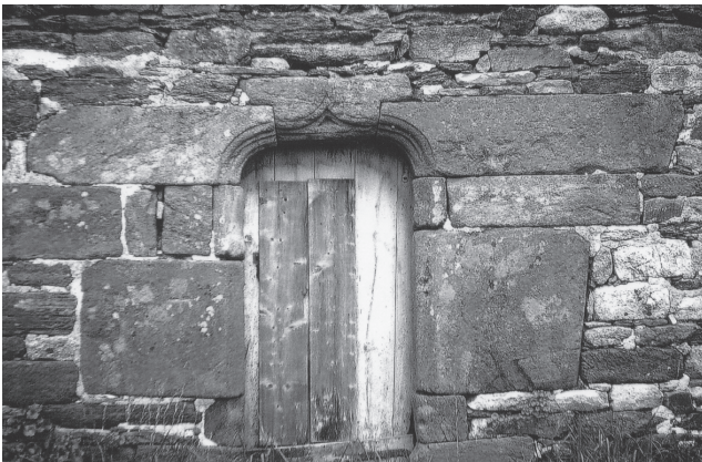
Photo X : Dans une ferme abandonnée à Saint-Couléo, en Tréméoc (Finistère), entourage de porte en grands blocs de prasinite (noter la clé de voûte caractéristique).
