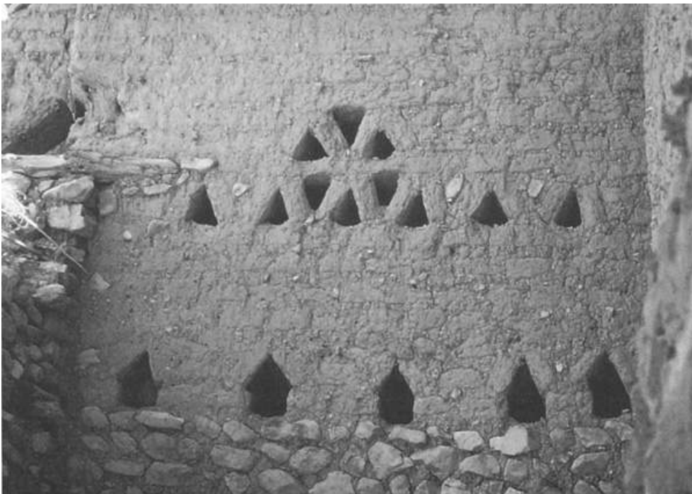
Ouverture en rosace dans une façade construite en toub à Menaâ (photo S. Adjali).
