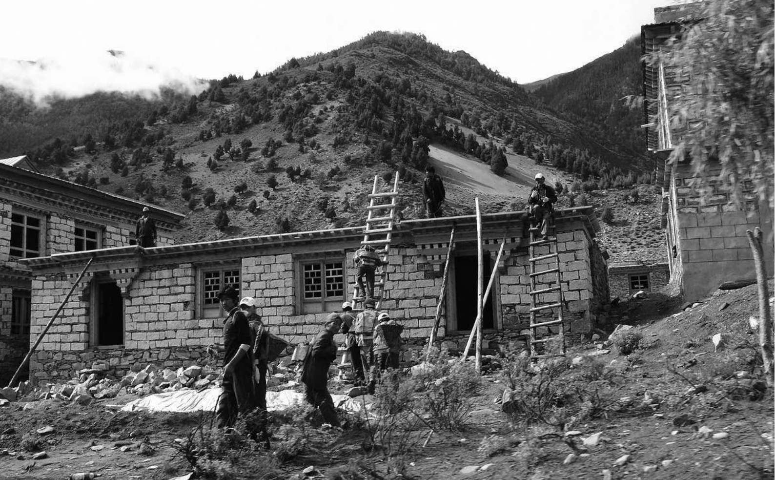
Construction d'une nouvelle maison, Kongpo, RAT.
